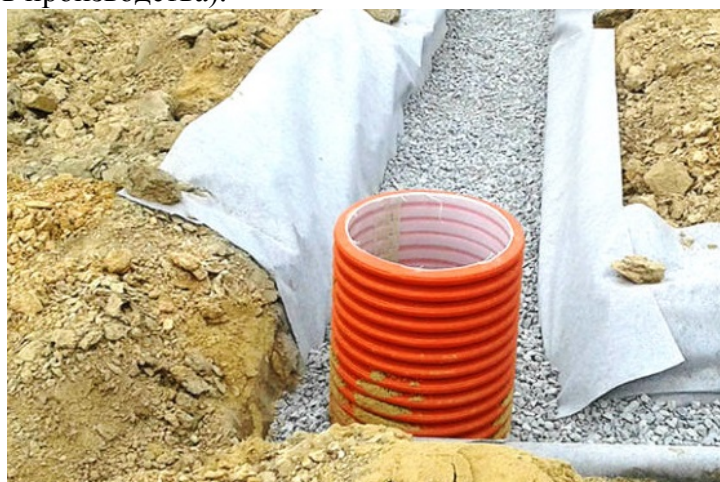
Рис.3. Применение геоткани для дренажной системы
