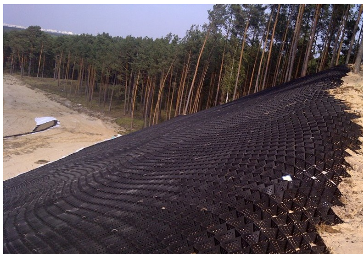
Рис.2. Применение геосетки для обустройства откоса насыпи
