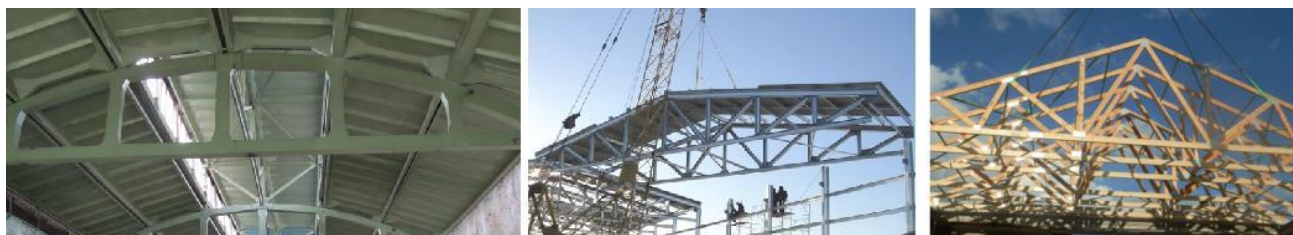
Рис.4.14. Общий вид вариантов покрытия здания
