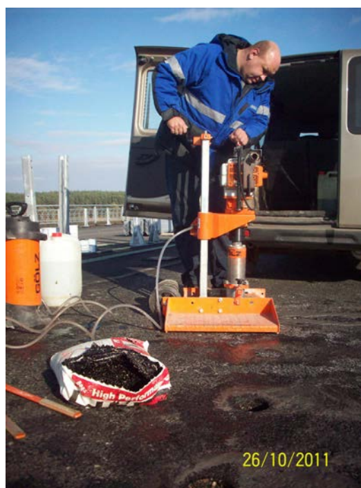
Рисунок 5.12 – Отбор кернов из покрытия ЩМА-15.
