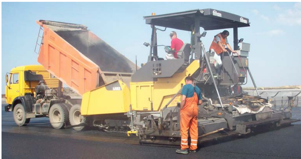
Рисунок 5.10. – Укладка ЩМАС-15 асфальтоукладчиком ТИТАН 8820.
