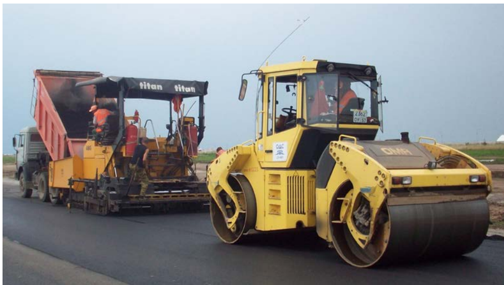
Рисунок 5.11. – Уплотнение ЩМАС-15 гладковальцовыми вибрационными тандемными катками.
